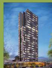
CRONOS TOWER UBERLÂNDIA/MG
