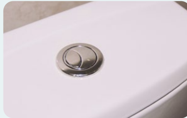
Sistema dual flush nos vasos sanitários
