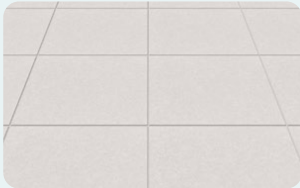
Revestimento cerâmico acima da bancada da cozinha
