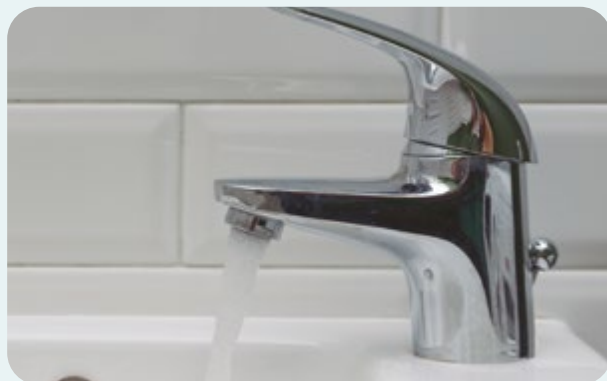
Arejadores nas torneiras das casas e áreas comuns
