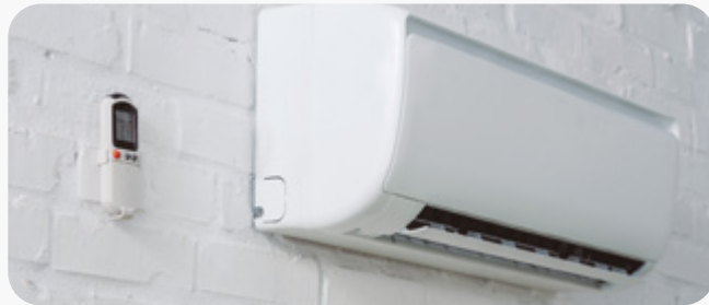
Preparação para ar-condicionado “split” em um dormitório
