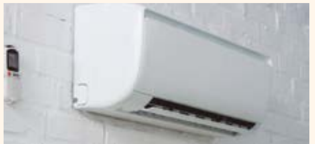
Preparação para ar-condicionado “split” em um dormitório Incluso cabeamento e disjuntores
