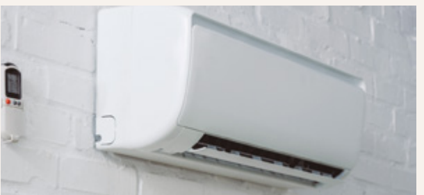
Preparação para ar-condicionado “split” em um dormitório
